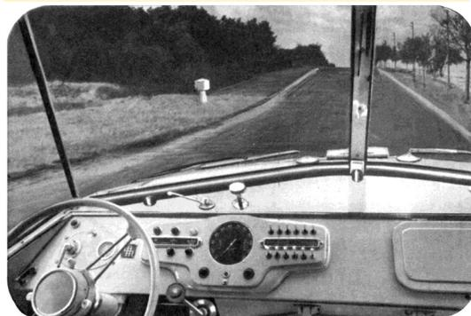
Le poste de conduite est très élaboré, avec des commandes (clignotant, code-phare, avertisseur) au moyeu de volant et un levier de vitesse horizontal
